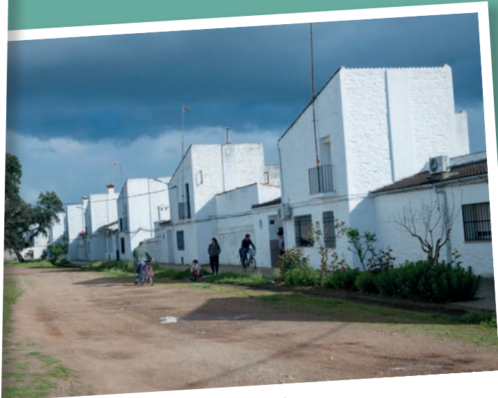
Conjunto de viviendas en Vegaviana, Cáceres. Página 126. Foto del arquitecto José Luis Fernández del Amo.
